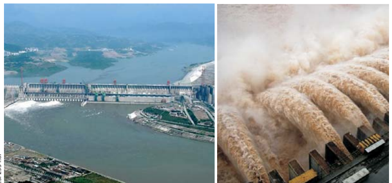
Bild 2 Ausbaustufe des Staudamms
