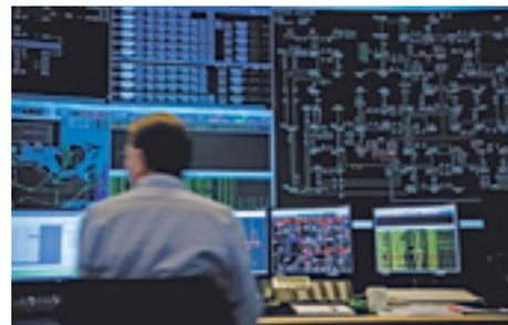
Auf Grundlage eines Siemens SIMEAS SAFIR Systems wurde für Energinet.dk eine leistungsfähige ENEAS-Lösung entwickelt. Ein standardisiertes Archiv speichert alle Störschriebe und Standard-Fehlermeldungen in einem einzigen System. Innerhalb des Intranet von Energinet.dk sind alle Daten über ein benutzerfreundliches Web-Interface abrufbar.
