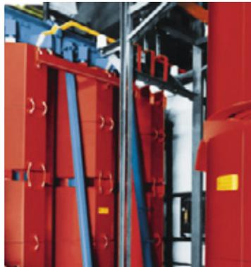
GEAFOL-Technik für ein Kaltwalzwerk in Russland: 6,1-MVA-Stromrichtertransformatoren,  $10 \pm 2 \times 5\% / 2 \times 0,78$  kV, Schaltung Dy5Dd0.
