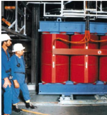
4,9-MVA-GEAFOL-Stromrichtertransformatoren für eine Goldmine in Südafrika 1700 m unter der Erde bei 90% Luftfeuchtigkeit.
