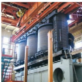
Extracción de la parte activa de un transformador para reparación o para reemplazo según se requiera.
